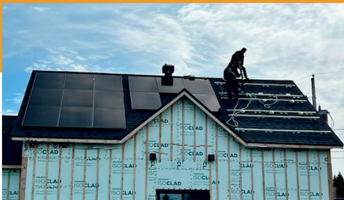
Installation de 37 panneaux solaires à Chicoutimi.
