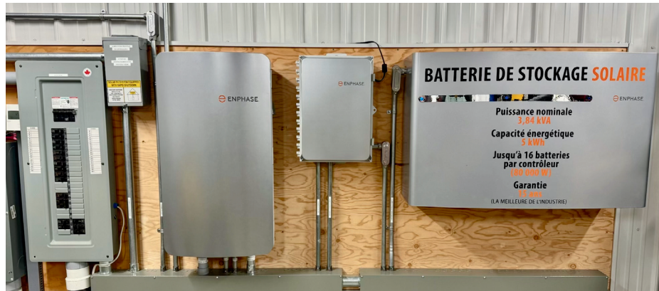
Installation avec batterie intelligente pour l'autoconsommation et l'utilisation en cas de panne du réseau, à Laterrière.
